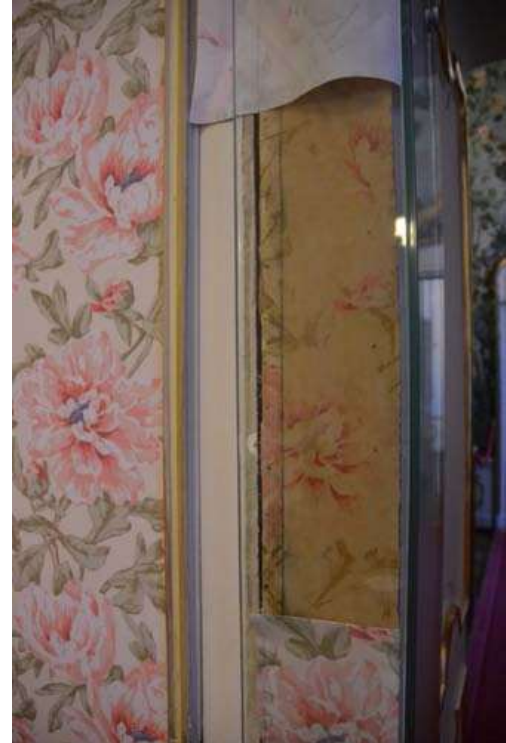
Ill 7. Detail. Rekonstruktsiooniga kaetud seinal jäetud „aken“, mis jätab võimaluse originaalseinakatet ja selle seisukorda vaadelda.
