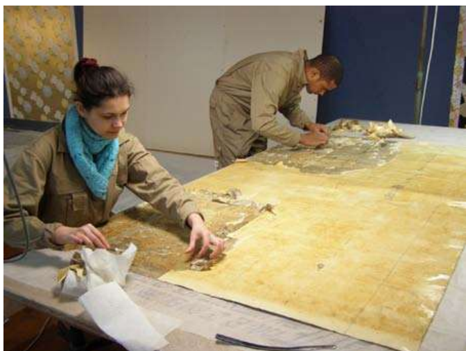
Ill 35. Üldjuhul on soovitatav kõrge ligniinisaldusega makulatuurpaber objektilt eemaldada. Eemaldamismeetod sõltub paberi ja kleepimiseks kasutatud liimi omadustest.
