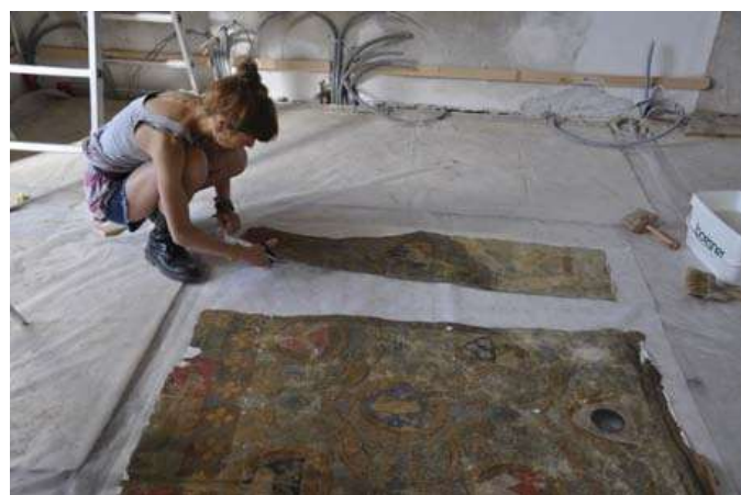
Ill 17. Tapeedi seinal kinnitamisel kasutati toestamiseks Hollytexi. Iga tükkile lõigati tema mõõtudele vastav riba.
