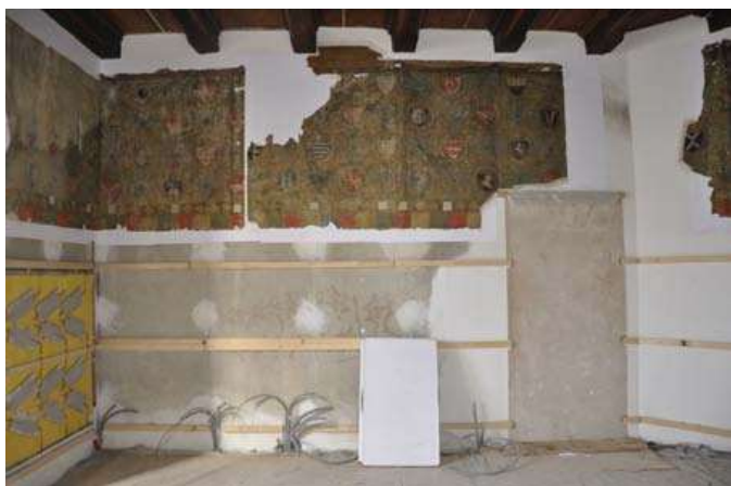
Ill 21. Tapeedid kinnitati seinale suvalises järjestuses, sest need sooviti hiljem puittabveldisega katta. Tapeeditükide algse järjestuse taastamiseks oleks kaasa aidanud dokumentatsioonifotod ja joonised.
