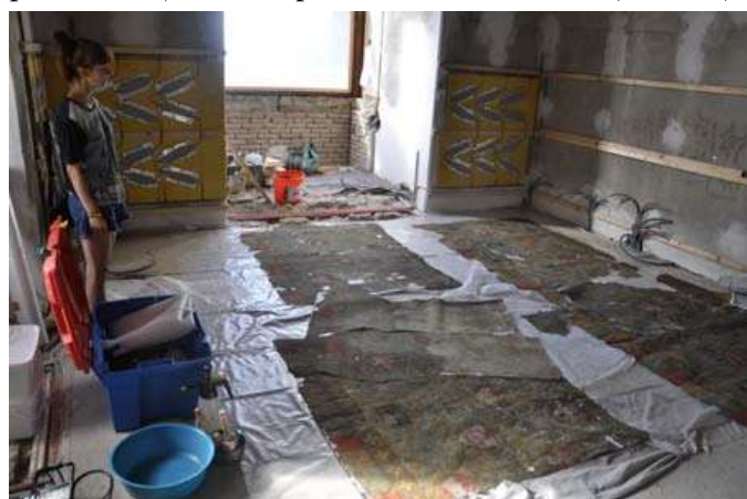
Ill 16. Enne tapeedi seinal kinnitamist järjestati tükid põrandal. Selleks, et tapeet ei määrduks, tuli põrand katta ehituskilega.
