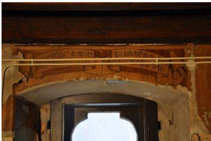
Ill 9. Seinal säilinud tapeedifragmendid enne puhastamist ning kinnitamist metüütselluloosi ja jaapani paberiga.
