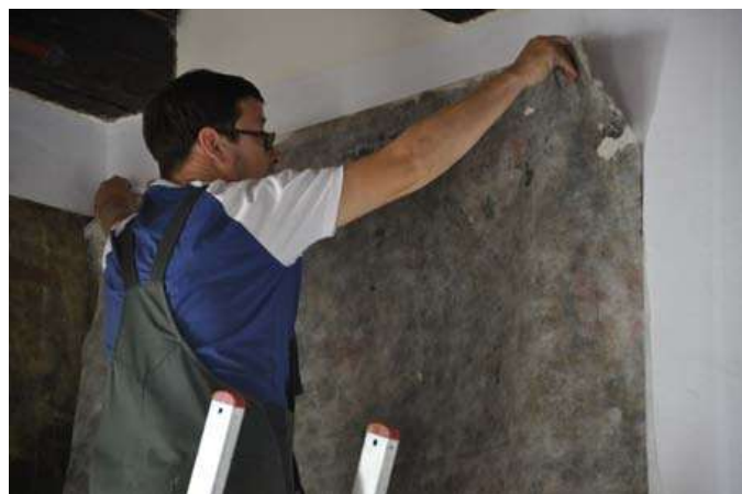
Ill 18. Hollytexi saab kasutada nii liimistatud tapeedi seinal paigaldamiseks kui ka selle obutuks eemaldamiseks.
