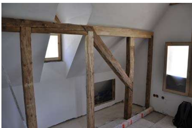
Ill 23. Tapeedi leiuruum, mida omanikud olid otsustanud edaspidi kasutada garderoobina. Puidust taladele kinnitatakse tapeetidega kaetud lükkanduksed.
